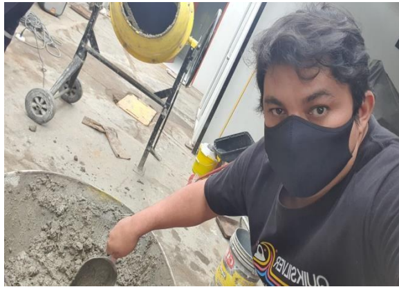
Figura 9. Mezcla del concreto.
