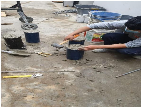
Colocación del Diseño de Concreto
