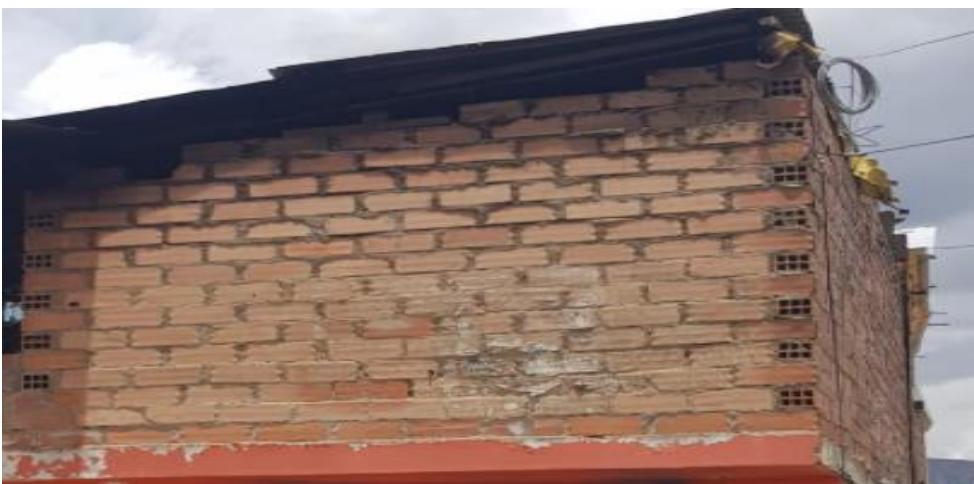
Fig.22 Muros de Ladrillo Pandereta.
