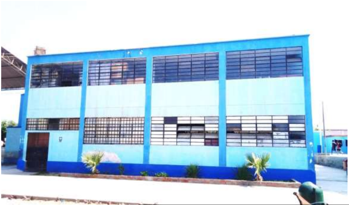
Columna Corta – Falla Inevitable en M2
