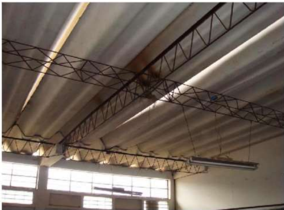
FOTO N° 01 : SE MUESTRA CONEXIONES ELECTRICAS EXPUESTAS Y EN MAL ESTADO
