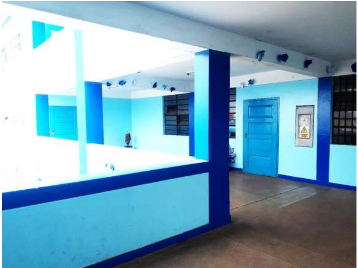
Columna Corta – Falla Inevitable en M1
