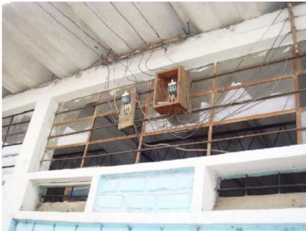
FOTO N° 01 : SE MUESTRA CONEXIONES ELECTRICAS EXPUESTAS Y EN MAL ESTADO
