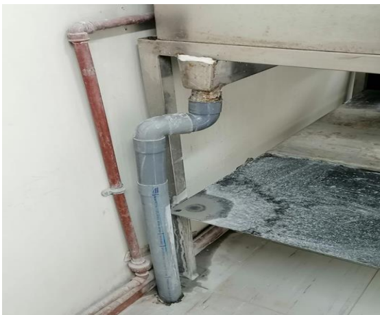
Fotografía 1: Ducto y cañerías con goteras y suciedad
