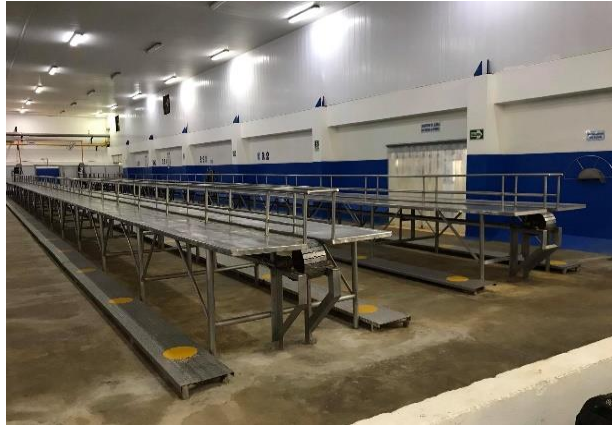
FIGURA 1. FAJA TRANSPORTADORA DE LA EMPRESA DON FERNANDO S.A.C
