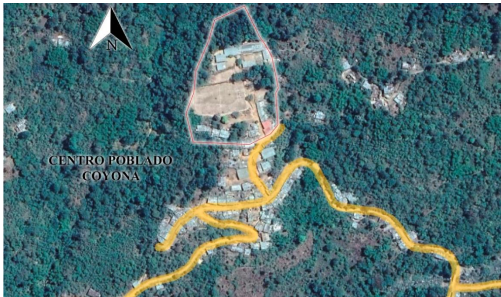
IMAGEN N° 12: VÍAS DEL CENTRO POBLADO COYONA
