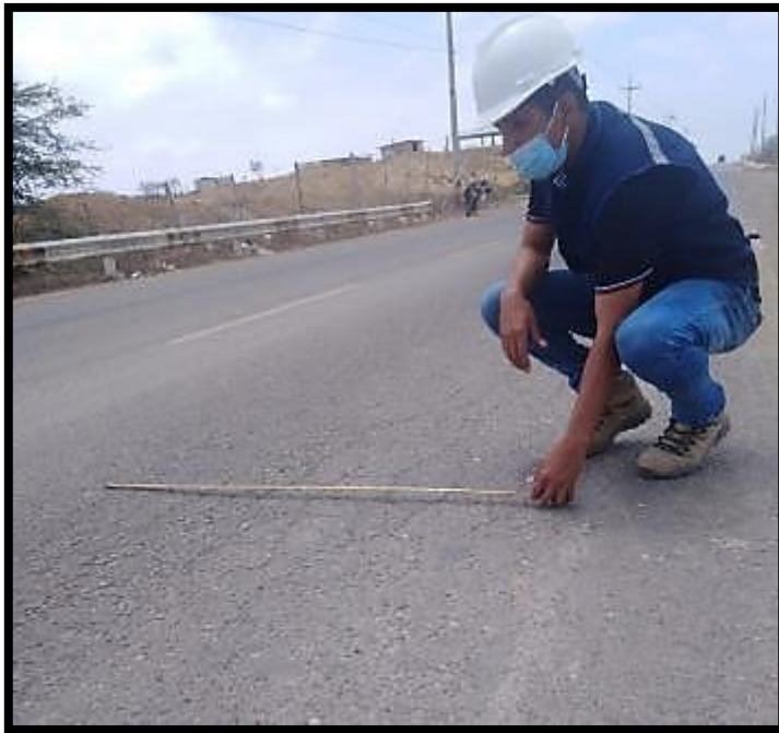
Imagen: Falla de tipo piel de cocodrilo
