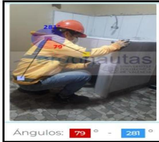
Figura 31. Evaluación de extremidades superiores colocación de cerámica
