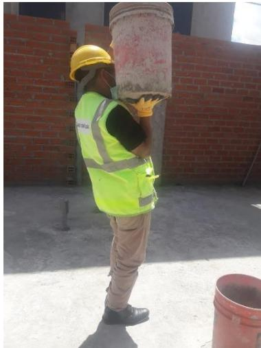
*Figura 43. Levantamiento de cargas destino encofrado y desencofrado*
