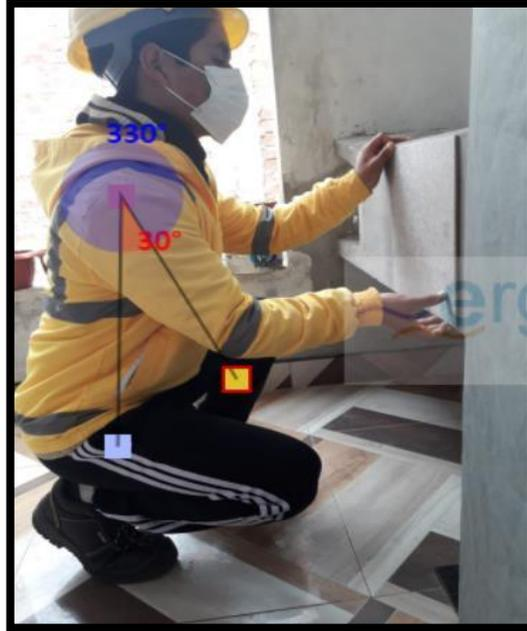
Figura 65. Evaluaciones de las extremidades superiores – colocación de cerámica
