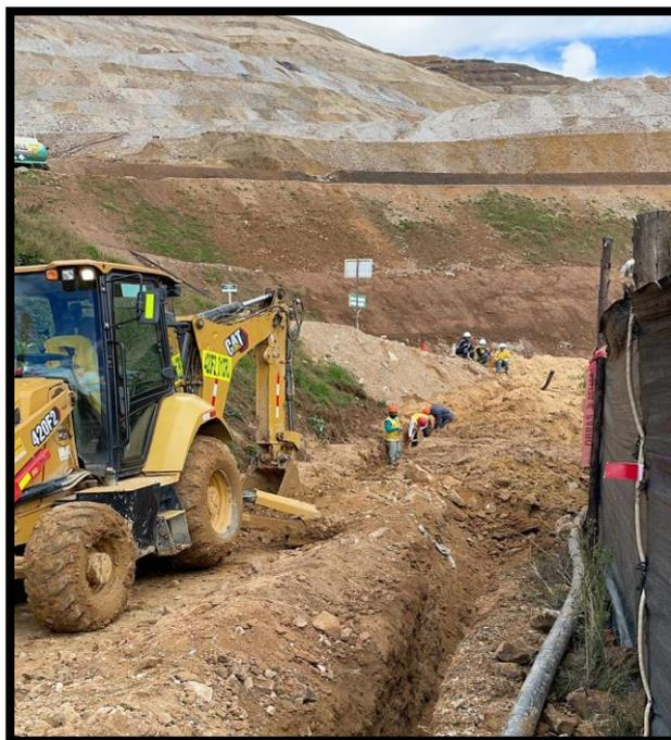
*Figura 91. Excavación de zanjas con mini retroexcavadora*
