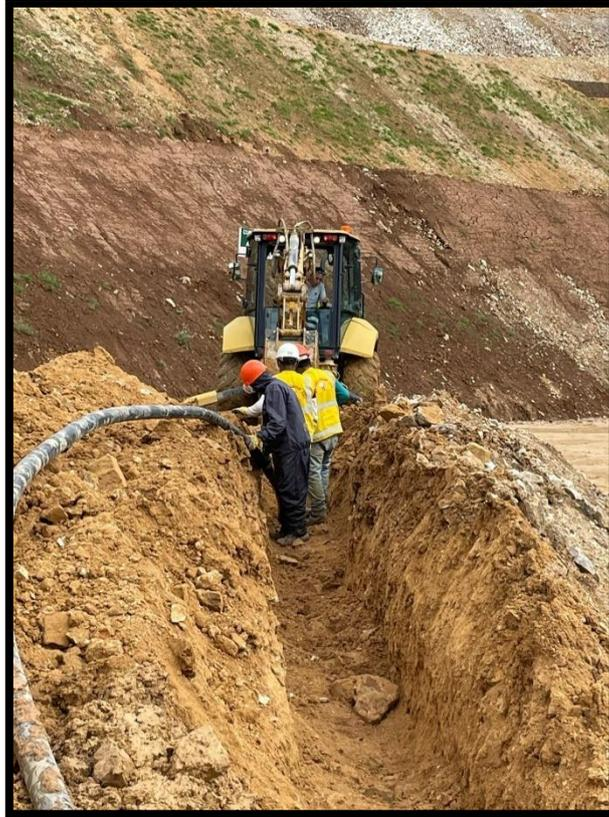
*Figura 90. Excavación de zanjas con mini retroexcavadora*
