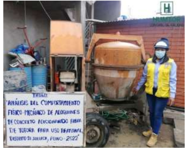
Fotografía 12: Equipo de la mezcla de concreto (trompo).
