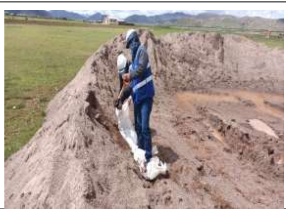
Fotografía 02: Extracción de material de AF (arena) en cantera.
