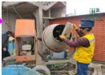
MEZCLA DE CONCRETO
