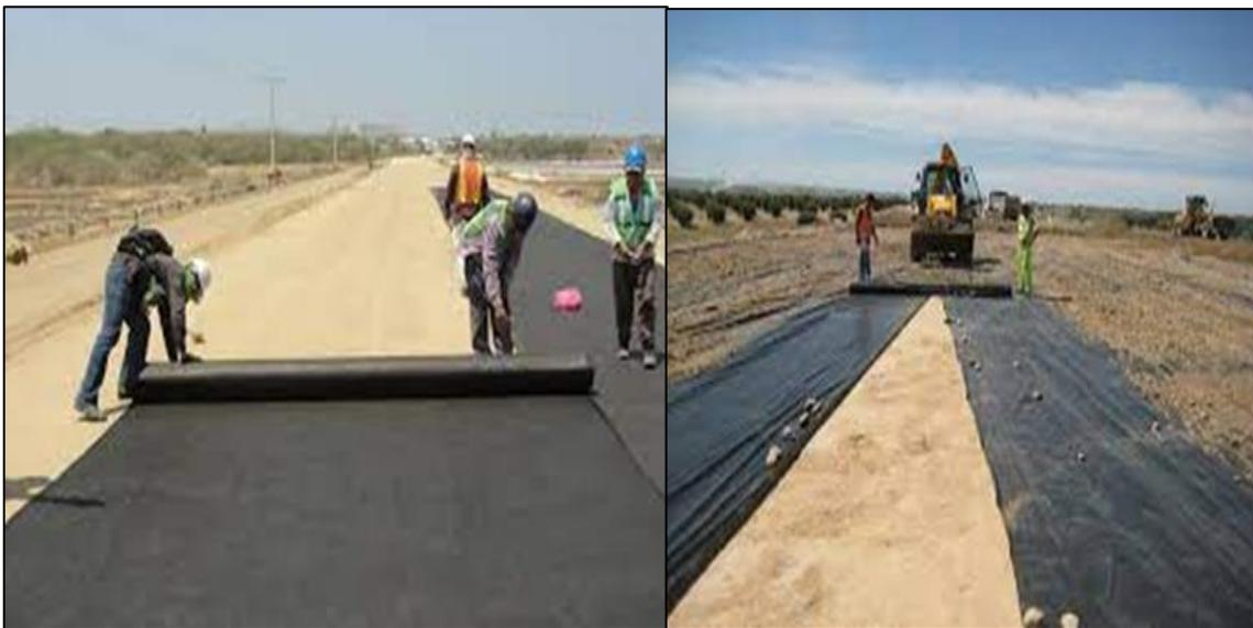
Figura N°1: Geotextil
