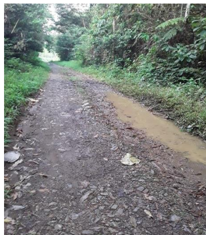
Fig1.2 Estado de la carretera
