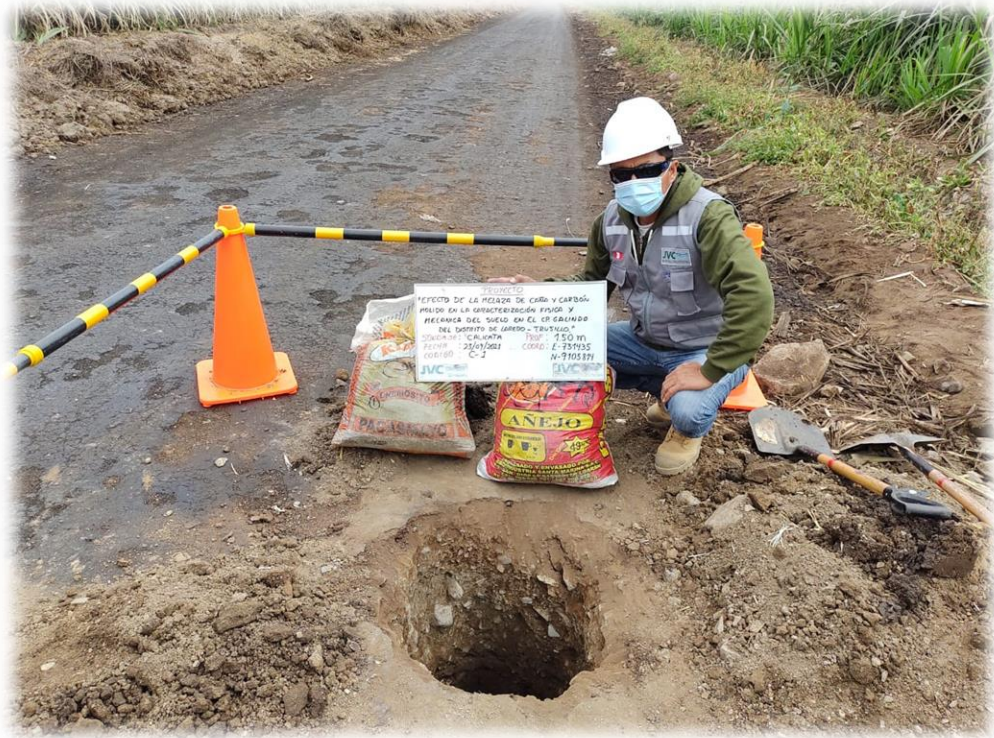
FOTO N°1: TOMA DE MUESTRA DE CALICATA 1.
