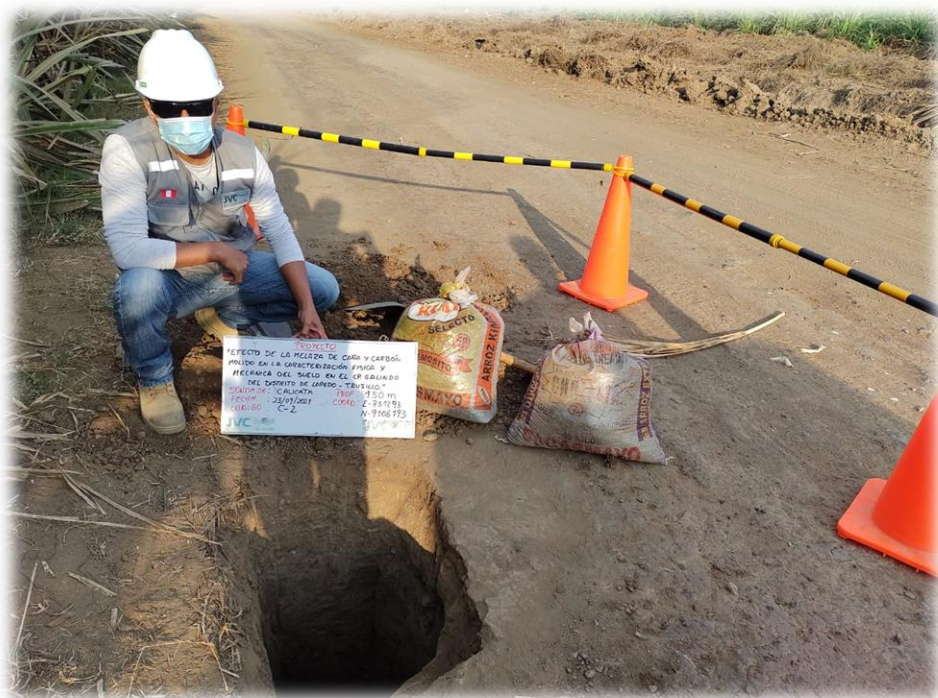
FOTO N° 2: TOMA DE MUESTRA DE CALICATA 2.
