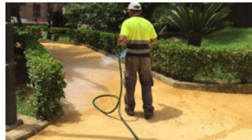
El pavimento terrizo continuo es adecuado para parques, jardines entre otros, se integra al medio ambiente. Este tipo de pavimento se logra a partir de la mezcla del terreno existente y una pequeña proporción de conglomerante y aditivos de estabilizador de suelos para mejorar sus propiedades mecánicas y evitar las emisiones de polvo, controla la erosión y el crecimiento de malas hierbas.
