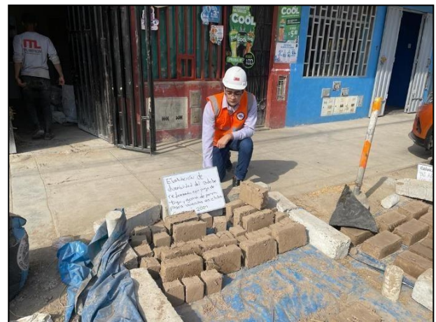
Figura 12. Secado del adobe Fuente: Elaboración propia
