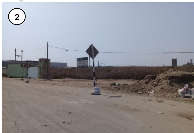
Figura 85. Características del terreno - Estado actual 2
