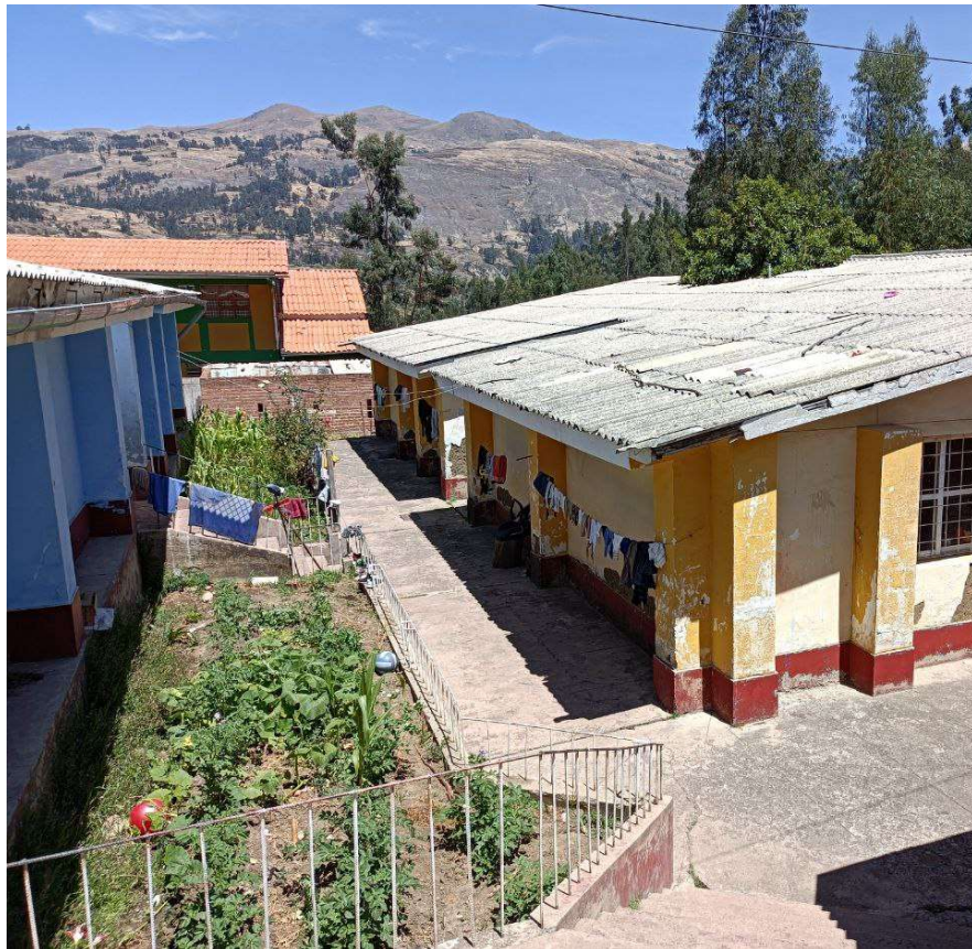
Fachada principal del Bloque D- Dormitorios 02
