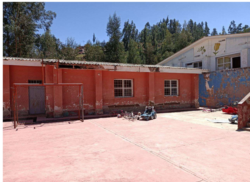
Fachada principal del Bloque E - Taller Recreativo
