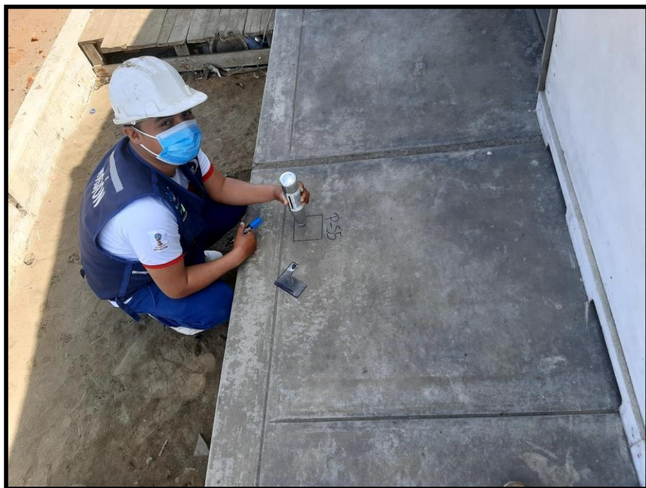
Imagen N°02, Usando el esclerómetro en el pavimento de vereda número 55.
