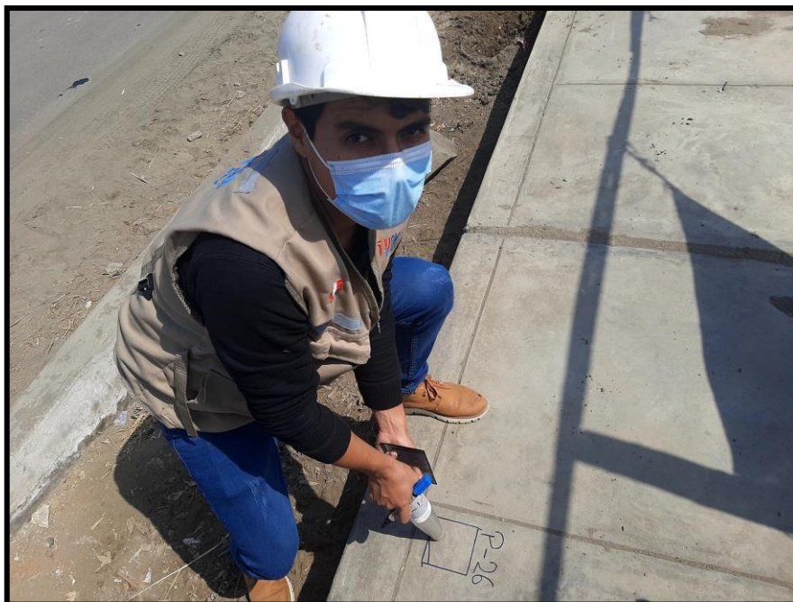
Imagen N°04, Usando el esclerómetro en el pavimento de vereda número 26.
