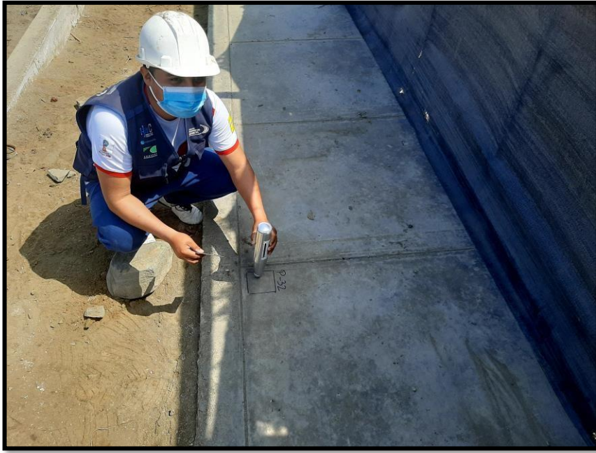
Imagen N°03, Usando el esclerómetro en el pavimento de vereda número 32.
