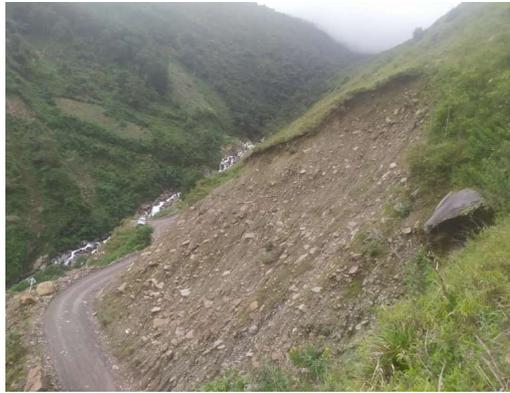
Fotografía 13: Talud con riesgo de deslizamiento.
