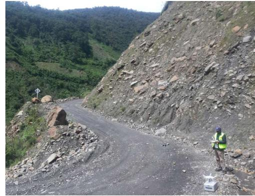
Fotografía 14: Planeamiento de vuelo con dron levantamiento de topografía.
