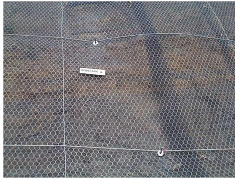
Figura 18. Detalle de mallas metálicas ancladas con pernos
