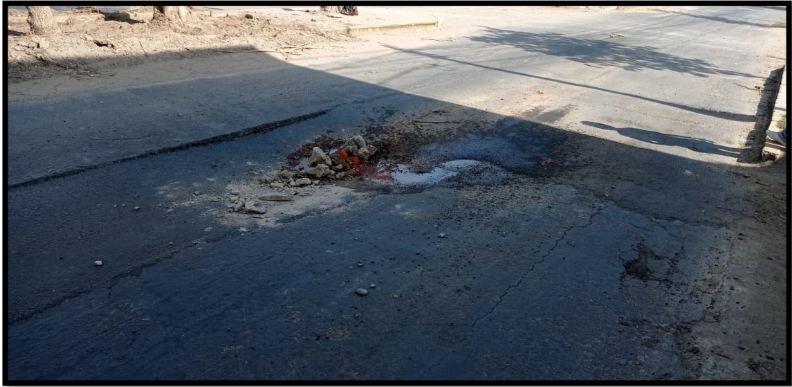
Figura 9. Abultamientos y hundimientos
