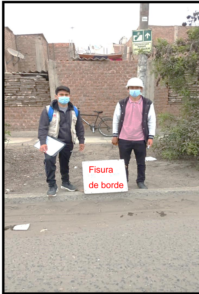
Figura 10. Fisura de borde
