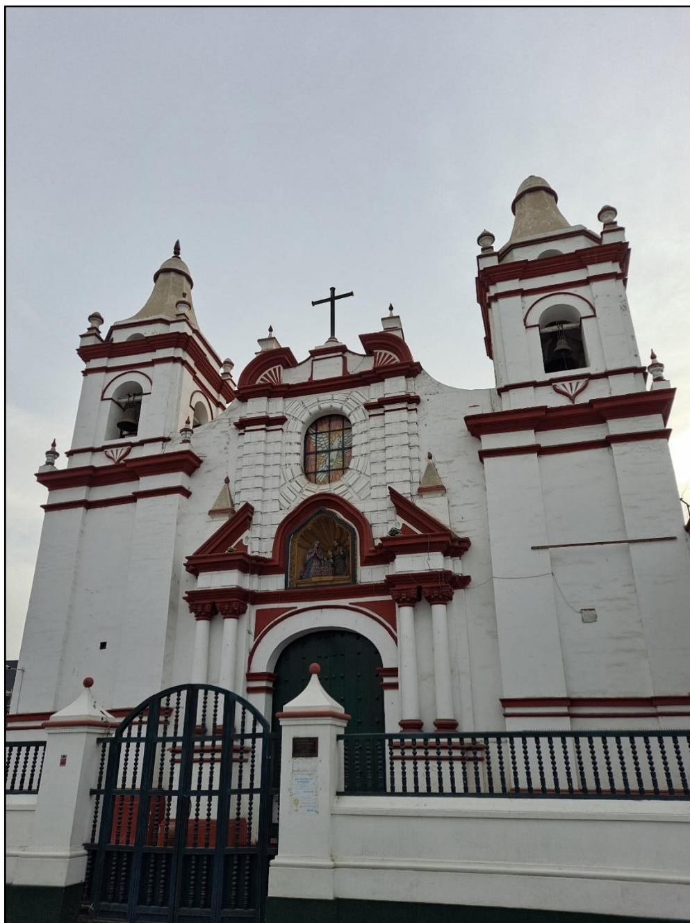
Figura 37. Iglesia Belén Actual - Fachada con presencia de elevadas torres, pináculos y otros elementos no estructurales mal conectados.
