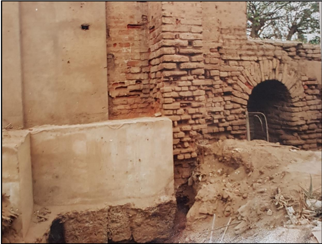
Figura 54. Iglesia Santa Ana - Evidencia de muros compuestos por ladrillo.
