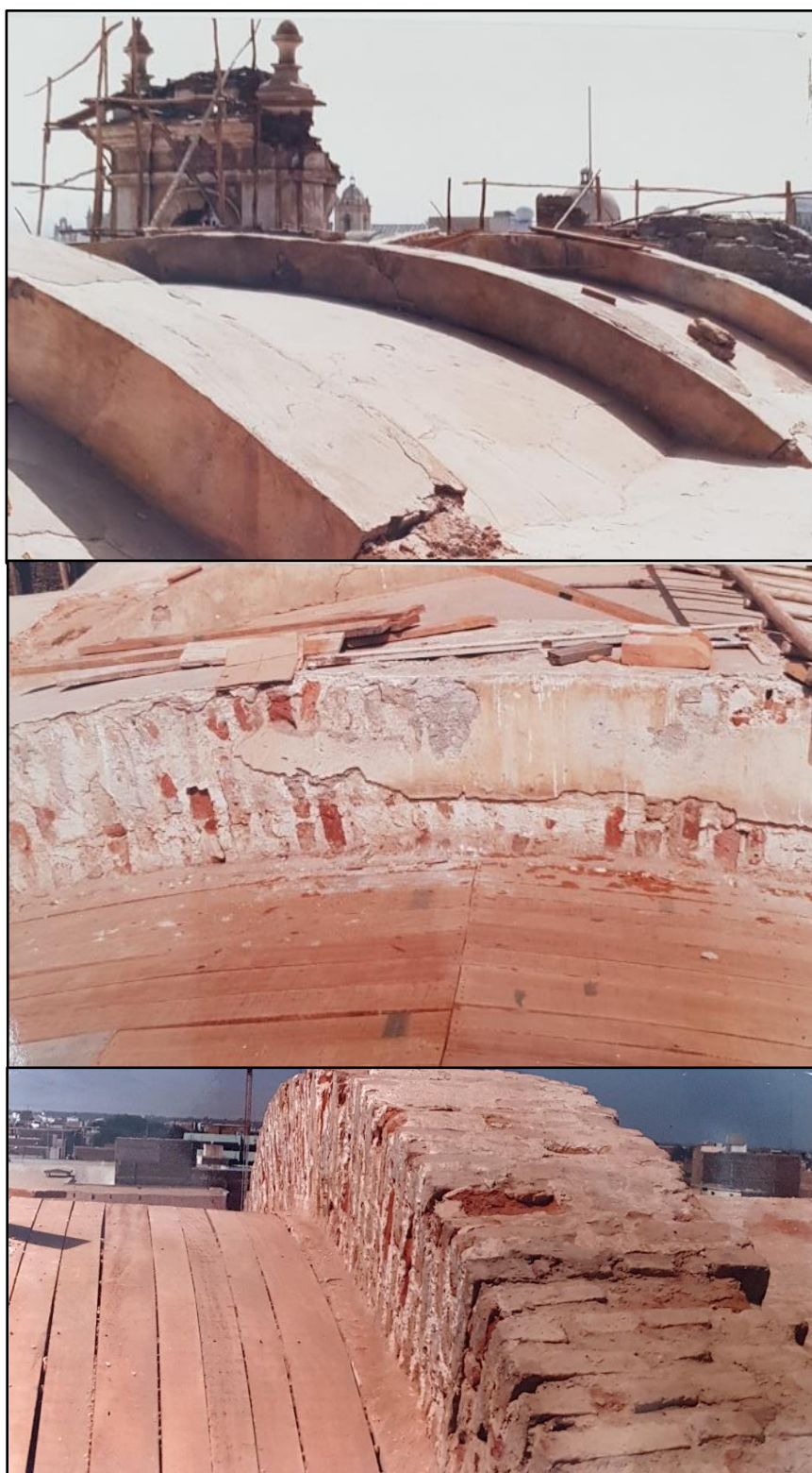
Figura 43. Iglesia Belén – Evidencia de arcos compuestos con unidades de ladrillo.
