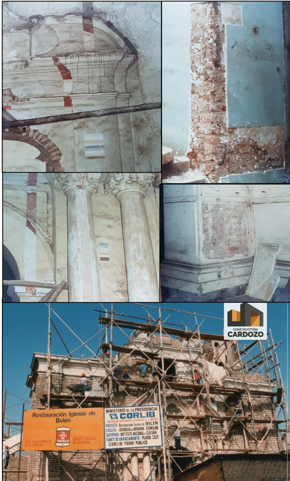
Figura 42. Iglesia Belén – Evidencia de fachadas y bases de arcos compuestos con unidades de ladrillo.
