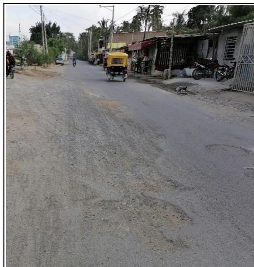
**FOTO N°02:** Distorsiones y deformaciones en la parte lateral del pavimento existente.
