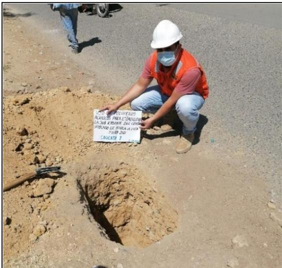
**FOTO N°07:** Excavación y extracción de la calicata C1, a una profundidad de 1.50 m, ubicada en la progresiva 0+000.
