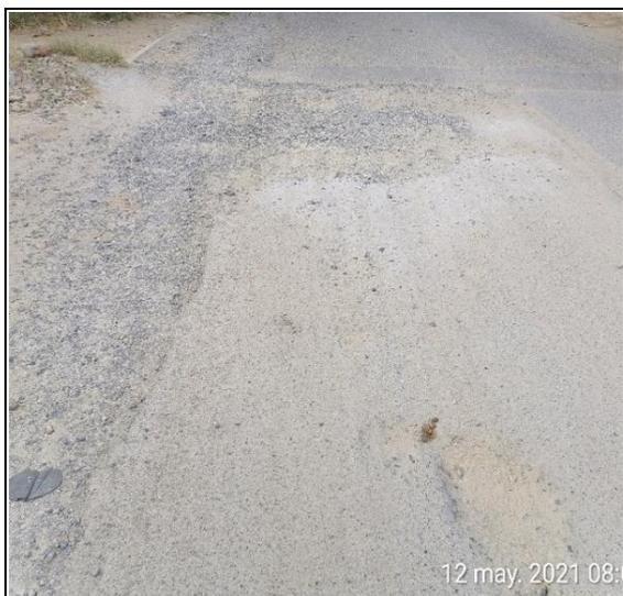
**FOTO N°03:** Grietas, ahuellamientos y desprendimientos de la carpeta asfáltica en el lado derecho.
