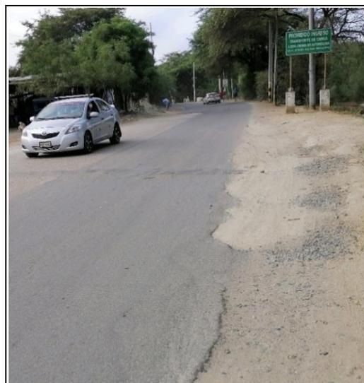
**FOTO N°04:** Desprendimiento de la capa de asfalto en los bordes del pavimento flexible.
