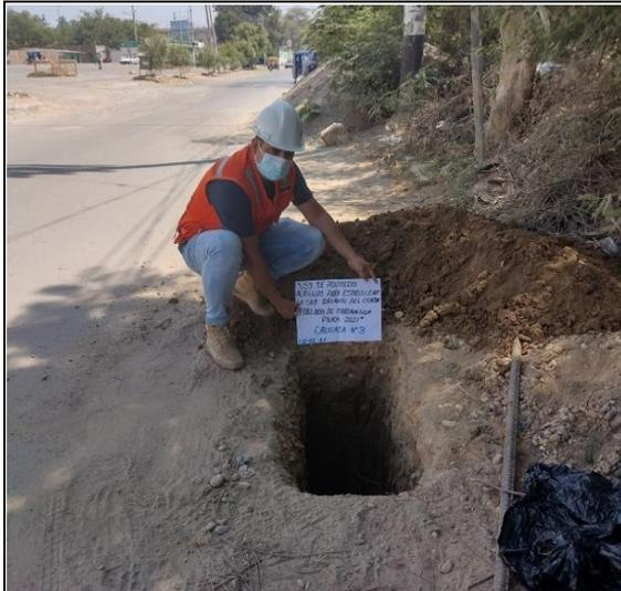
**FOTO N°09:** Excavación y extracción de la calicata C1, a una profundidad de 1.50 m, ubicada en la progresiva 0+400.
