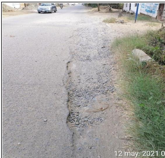
**FOTO N°01:** Distorsiones y deformaciones en la parte lateral del pavimento existente.
