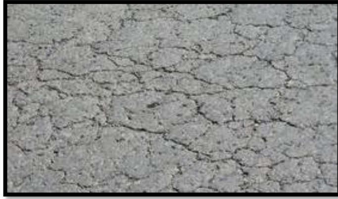
Figura 2. Piel de Cocodrilo Fuente: Elaboración Propia
