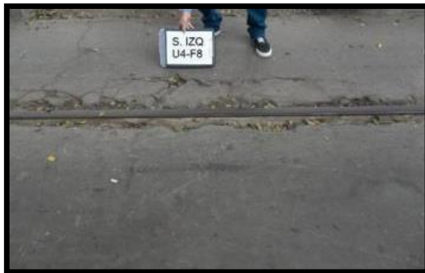
Figura 17. Cruce de Vía Férrea Fuente: ROBLES, Raúl (2015)
