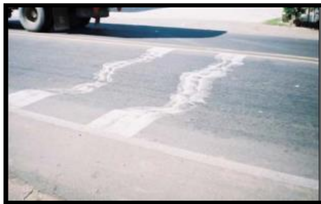
Figura 18. Ahuellamiento
