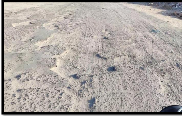
Figura 16. Huecos Fuente: Elaboración Propia
