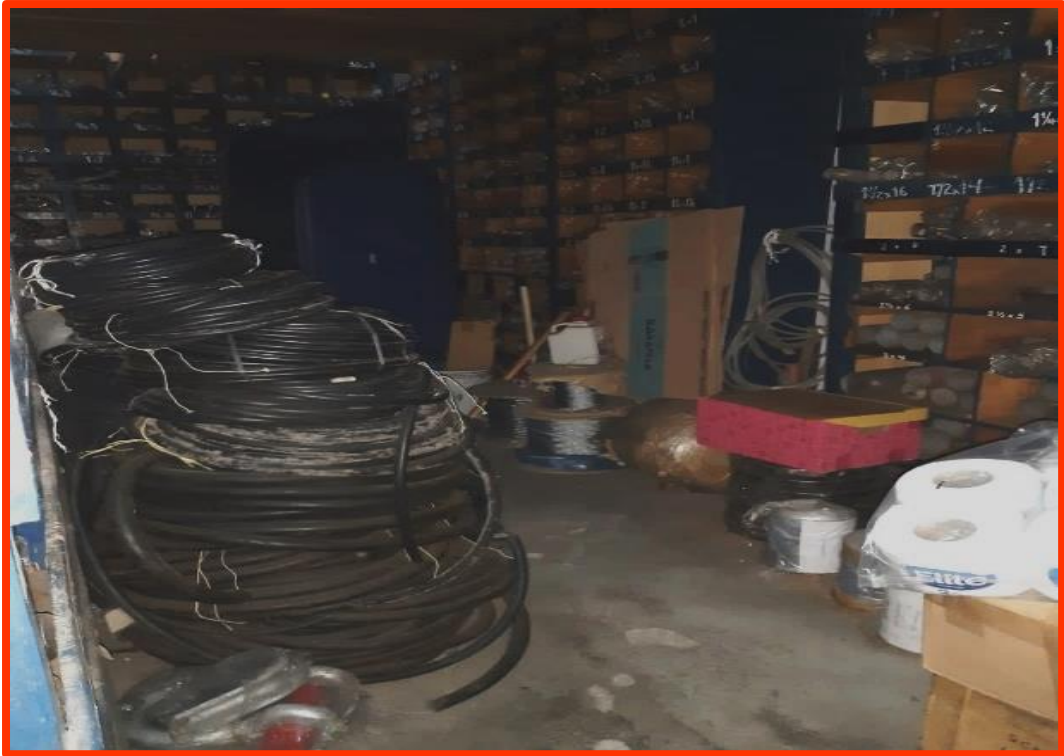
Figura 16. Zona de materiales de acero en el almacén antes de la mejora
