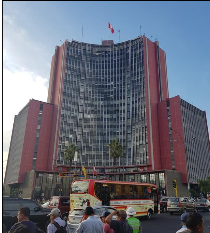
Figura 112. Edificio ex Ministerio de Educación. Recuperado de: https://www.archdaily.pe/pe/71646/clasicos-de-arquitectura-ministerio-de-educacion-enrique-seoane-ros
