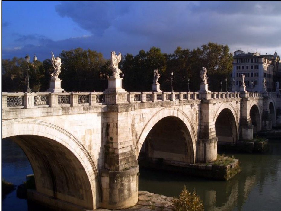
Figura 14. Puente Aelius, actualmente Ponte St. Angelo en Roma. Recuperado de: https://es.wikipedia.org/wiki/Anexo:Puentes_romanos#/media/Archivo:Ponte_St_Angelo.jpg
