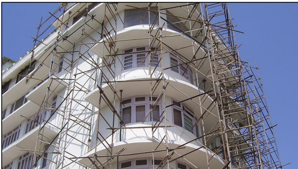
Figura 90. Rehabilitación de un edificio histórico. Recuperado de: https://trcpaint.com/rehabilitacion-edificios-construccion/?lang=ca
