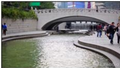
Canalización del agua, manteniéndola en niveles adecuados
