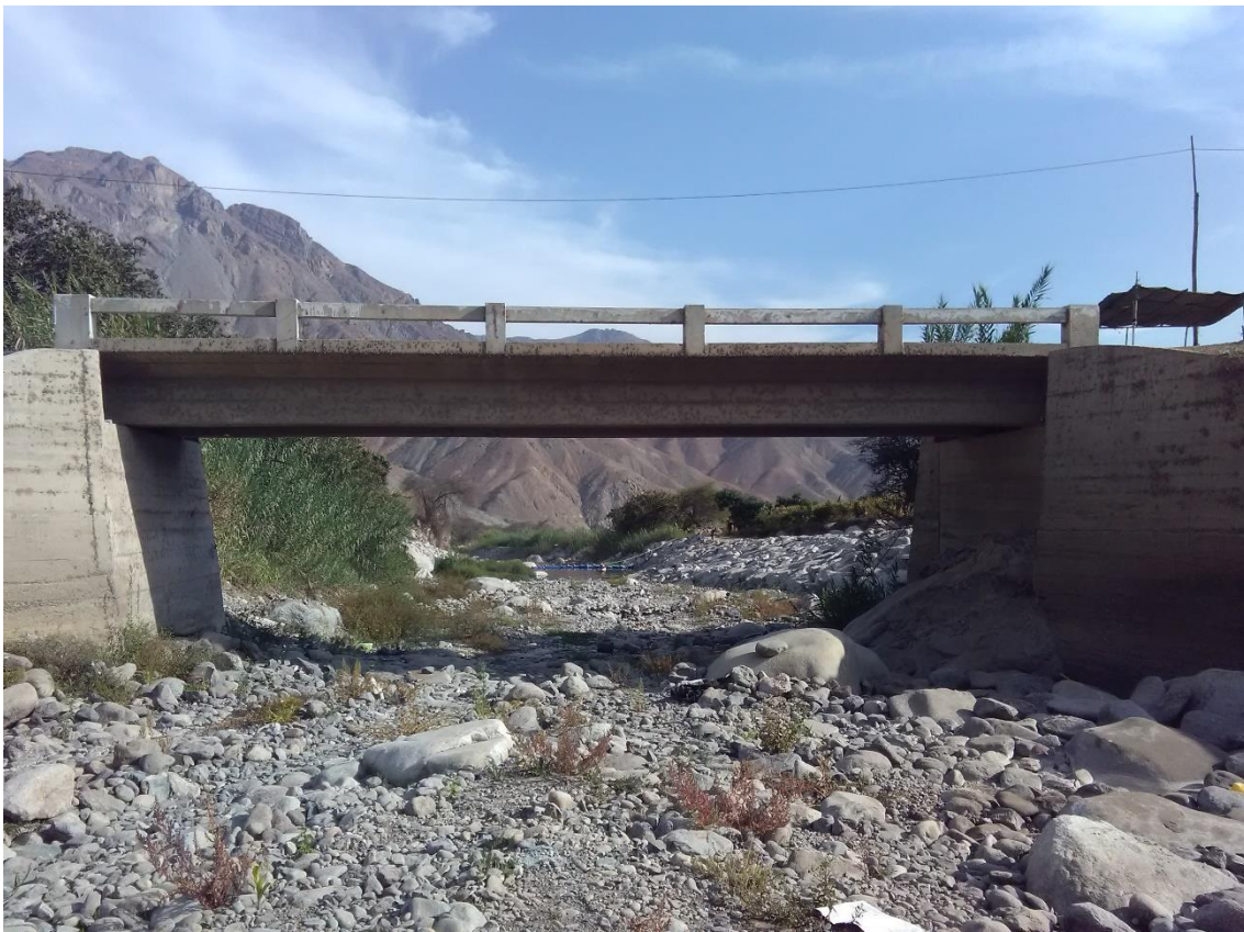
Puente en el rio Aija en Huamba Alta para la propuesta de instalación de sensor radar de cálculo de flujo continuo
