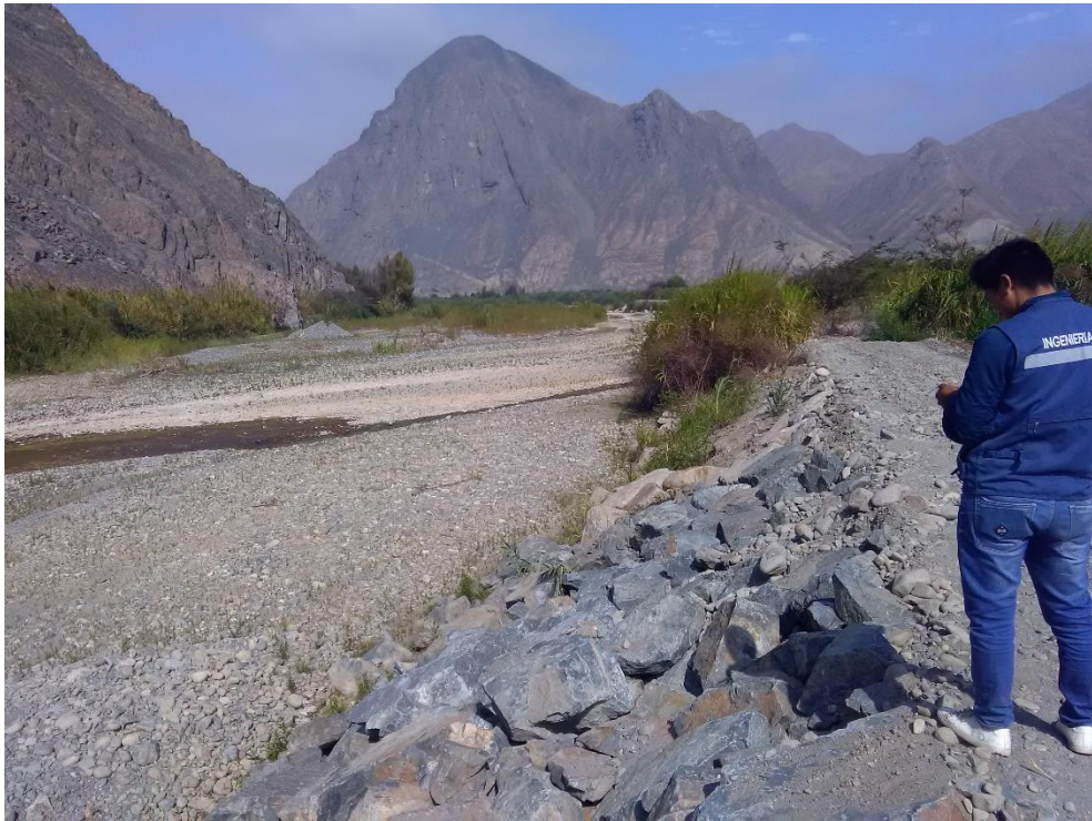
Parte media baja del rio huarmey vista aguas abajo (se aprecia la rugosidad del rio)
