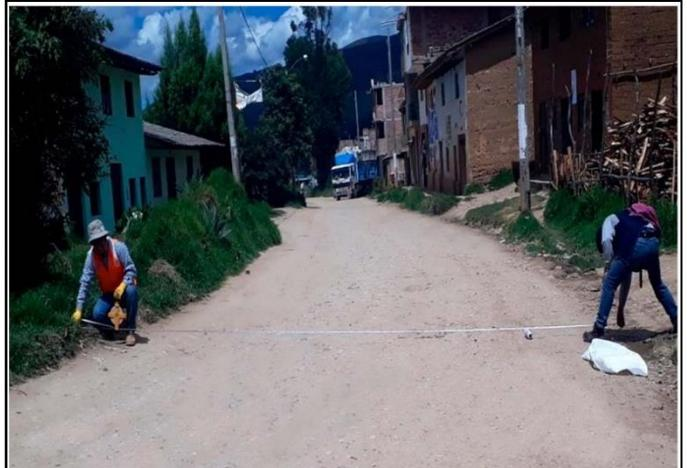
Foto N.º 04: Vista del ancho de superficie de rodadura y el estado actual de la vía y medición de Calzada. Km 00+320.00
