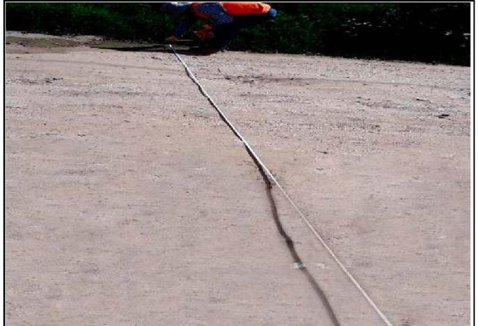
Foto N.º 06: Medición del Ancho de la Calzada en el tramo Km 00+370.00. - Km 02+200.00
