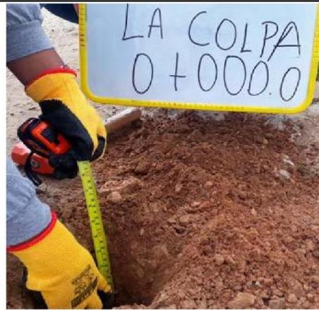
Foto N.º 02: Verificación del espesor de la superficie de rodadura en la progresiva Km 00+000.0
