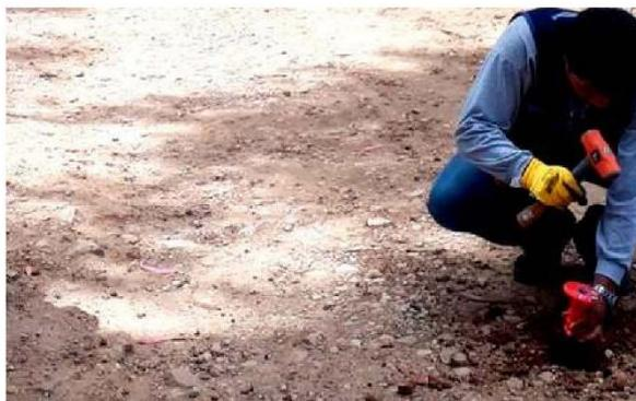
Foto N.º 08: Verificación del espesor de la superficie de rodadura de la carretera en la progresiva Km 01+500.00
