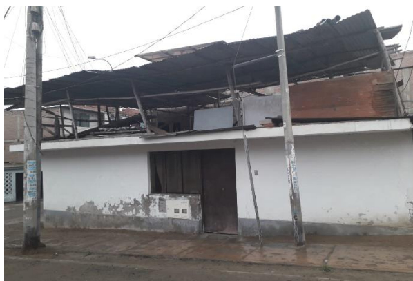
Figura 12. Vivienda localizada en pendiente
