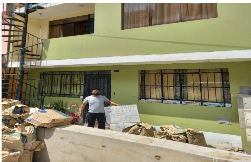
Figura 11. Vivienda sobre relleno natural
