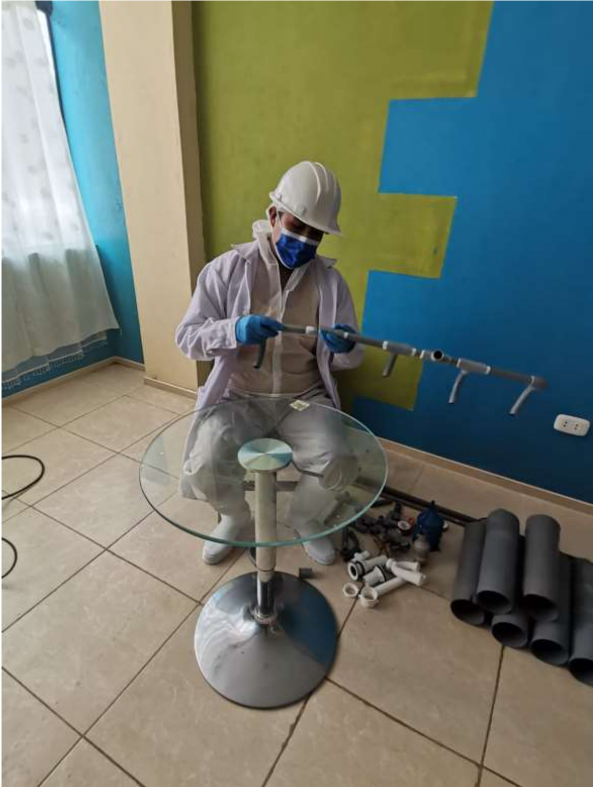
Figura 21. Proceso de conexión de sistema de biofiltración.
