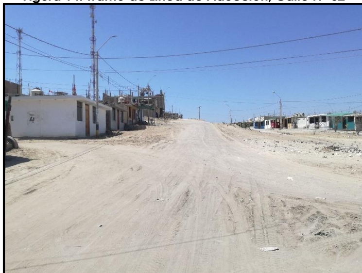
Figura 14: Tramo de Línea de Aducción, Calle N° 02
