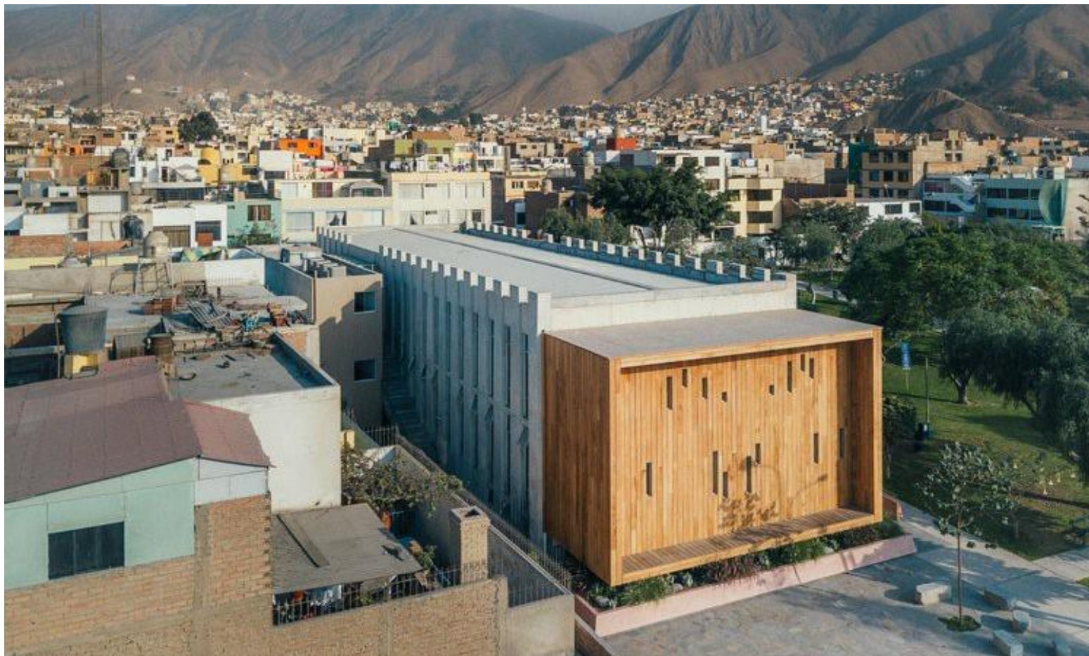
Figura 17: Vista Aérea, Plaza Biblioteca Lima Sur.
