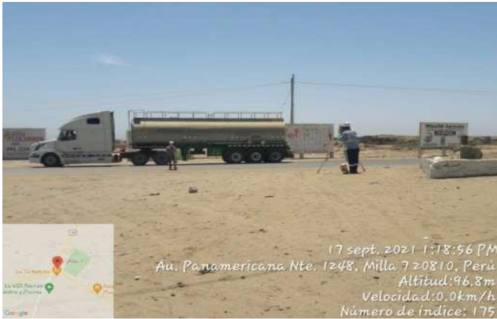
Fotografía 7. Levantamiento topográfico con estación total de intersección “La Campana” de Talara, Piura
