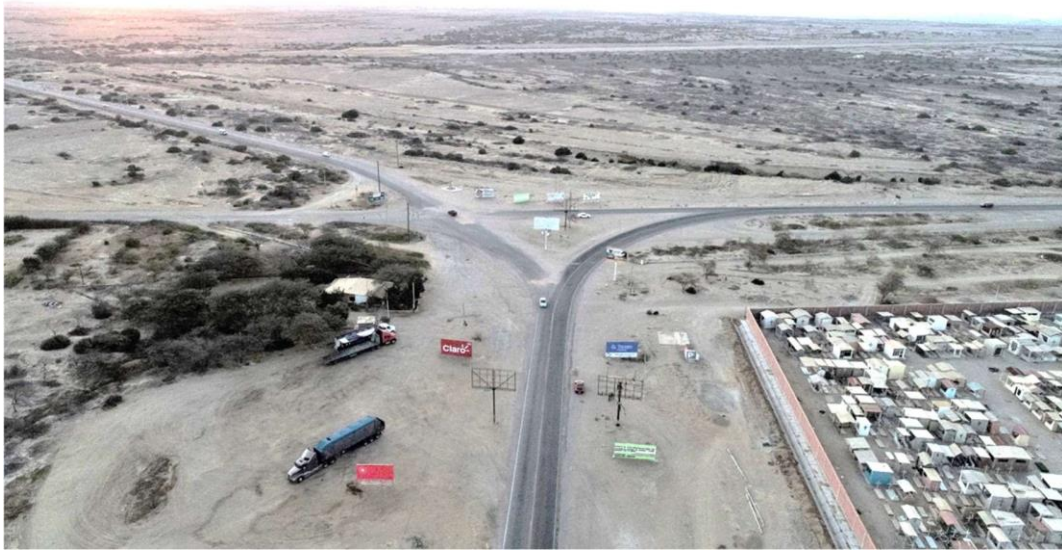
Figura 10. Vista panorámica de intersección La Campana, Talara, Piura.
