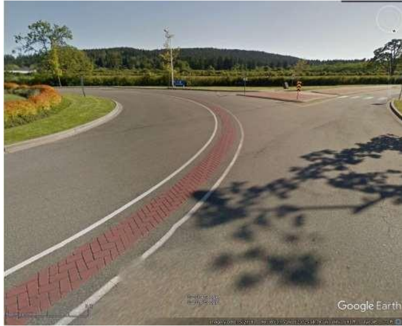
Figura 3: Ejemplo de separador de carriles en una turbo rotonda ubicada en el Aeropuerto Internacional Victoria (FHWA Safety Program, 2019).
