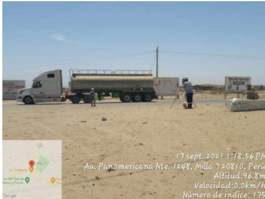
Figura 5. Levantamiento con estación total de la intersección “La Campana”, Talara, Piura.
