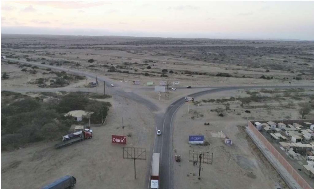
Fotografía 1. Vista aérea de la intersección “La Campana” de Tarma, Piura
