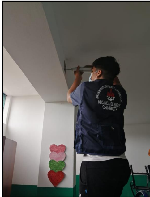
Figura 20: Ensayo de esclerometría en viga
