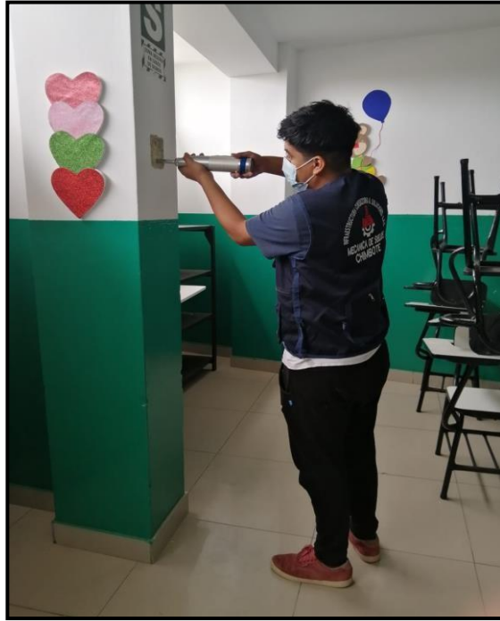
Figura 19: Ensayo de esclerometría en columna
