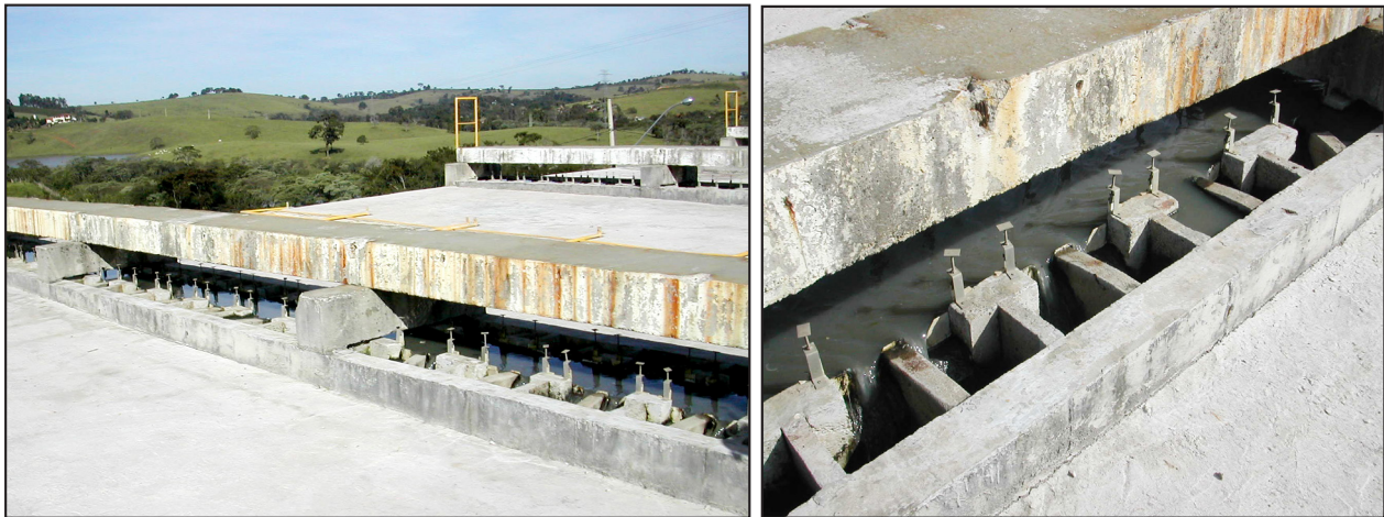
Fig. 5.40 - Canal longitudinal de distribución del agua residual afluyente: PTAR Santana – Varginha (COPASA MG)
