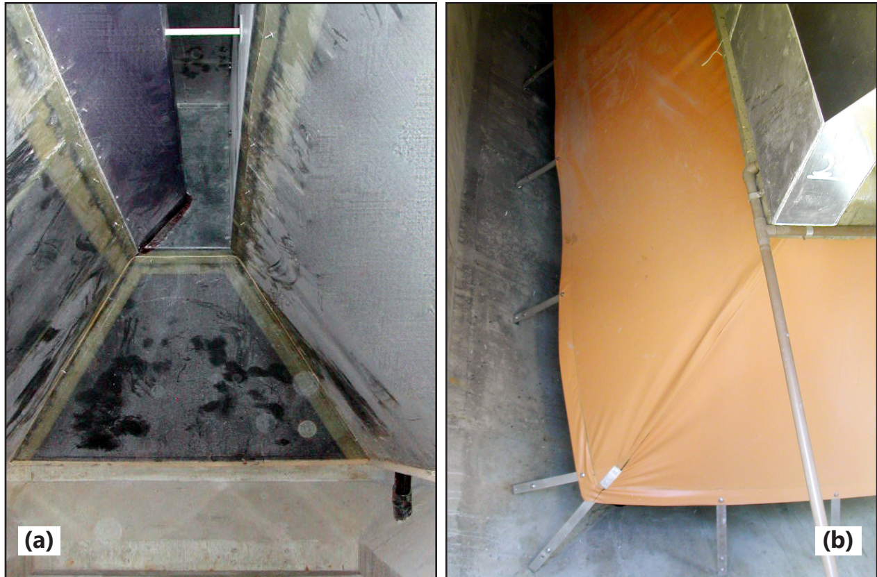
Fig. 5.57 - Modelos de separadores trifásicos confeccionados con materiales no corrosivos: (a) parte interna de un separador, en resina poliéster reforzado con fibra de vidrio; (b) parte externa de un separador, en lona, con tirantes de fijación en acero inoxidable
