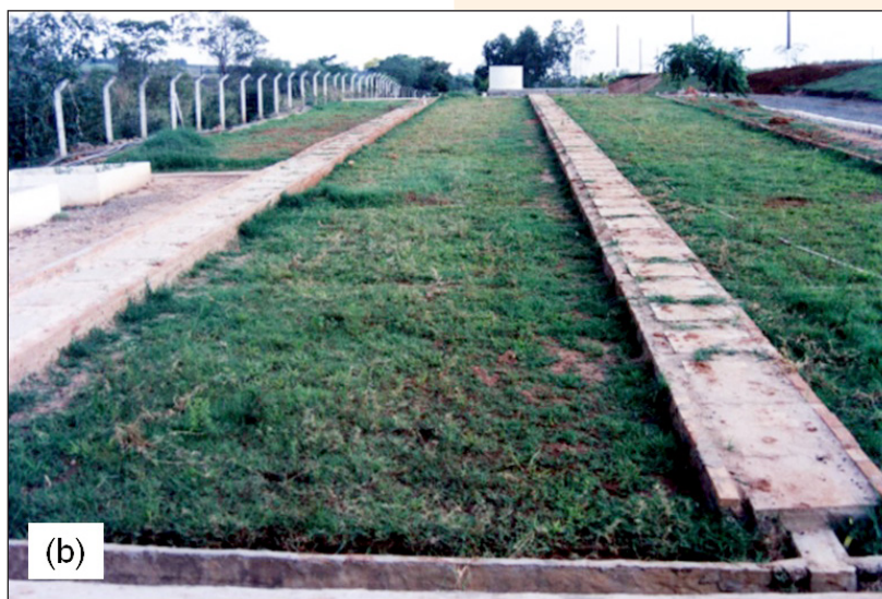
Fig. 7.4 - Vista de sistemas reactor UASB + escurrimiento superficial: (a) instalación experimental UFMG/SAAE Itabira; (b) instalación experimental UNICAMP.
