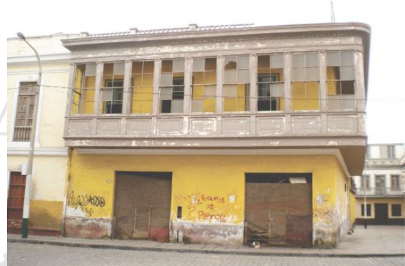
Balcón cerrado corrido con ventanas rectangulares
