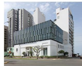
2012 Ampliación del 3er y 4to nivel
