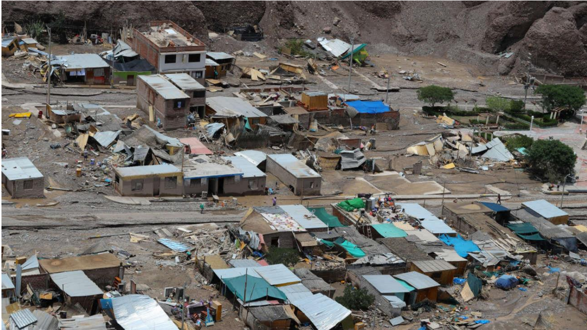
Fotografía aérea cedida este sábado por la Presidencia de Perú que muestra viviendas destruidas e inundadas por un deslizamiento de tierra en el distrito de Mirave, en Tacna. | Fuente: EFE | Fotógrafo: André Valle
