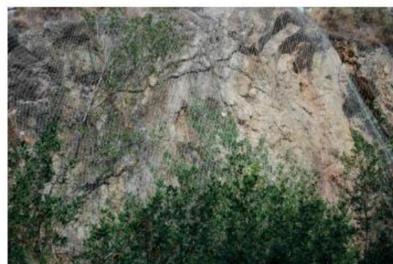
2 Reixa metàl·lica de contenció en talús/pedrera
