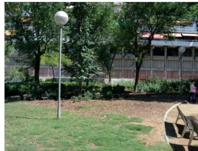
2 Parterre de gespa i zona d'arbustives en mal estat
