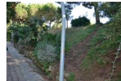
9 Talús pronunciat parcialment cobert
