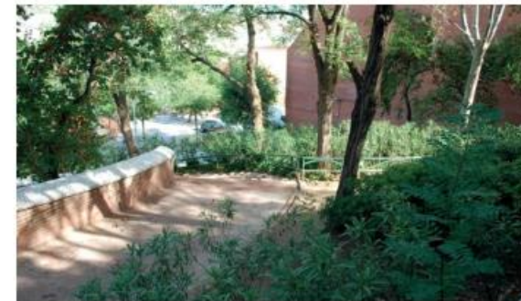
3 Masses arbustives, mur i barana metàl·lica
