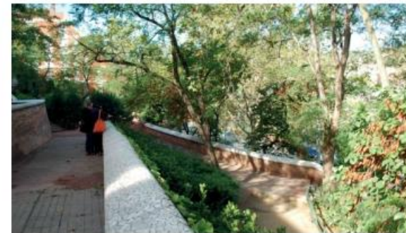
2 Murs amb ceràmiques i canvis de paviment
