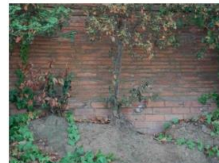
10 Detall del descalçat dels marfells
