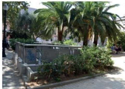
6 Tanca arbustiva de pitòspor en mal estat
