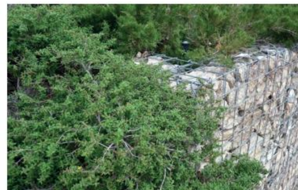
Imatge de referència de mur de contenció de pedra i arbusts
