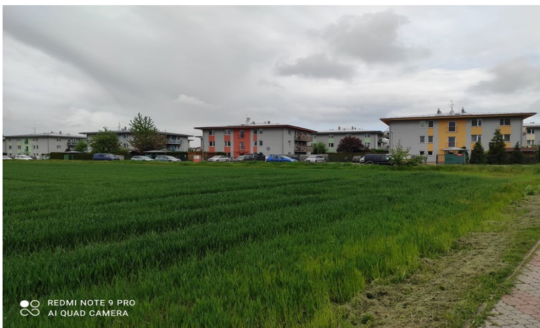
Obrázek 1 Bytový komplex na okraji čtvrti Cyrilov (foto: autor)
