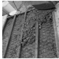
Fig. 2: MMO Ti mesh counter electrode
