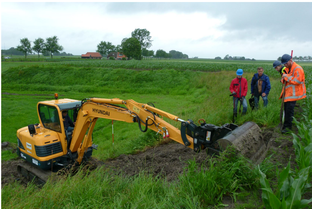
Fig. 2. Het opnieuw blootleggen van een deel van het profiel in Anjum: met een minikraan wordt de losse grond die in 2006 tegen het profiel is teruggeplaatst weer verwijderd (foto. D. Postma, RUG/GIA).
