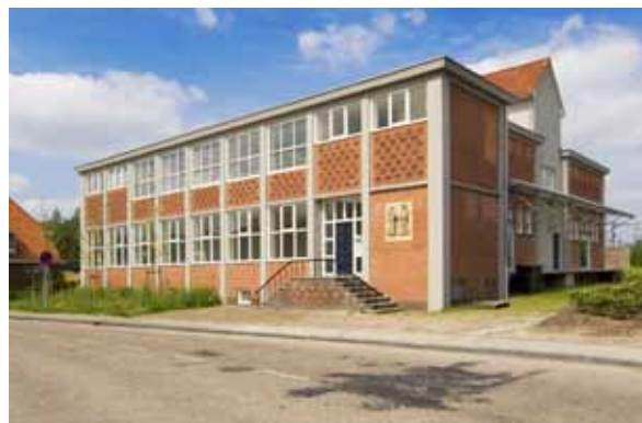
Kantoorpand van DAAD in Beilen
