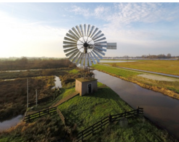
Afbeelding 69 De Ameri- kaanse windmotor aan de polderdijk slaat het water uit polder de Veenhoop uit op de polderringvaart. Foto: Fred Kok.
