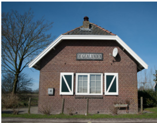
Onder, afbeelding 81 Sluiswachtershuis de Gealanden. De sluis zelf is inmiddels niet meer aanwezig.
