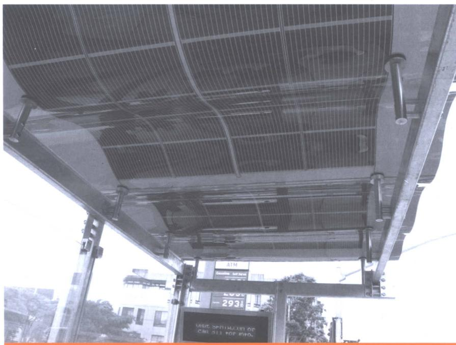
Abb. 1a: Kunststoff PV-Zellen in den ersten Anwendungsprodukten. Bushaltestelle mit Dach aus Kunststoff PV-Zellen in San Francisco von 3Form/Konarka; © Matthew Roth (2009)
