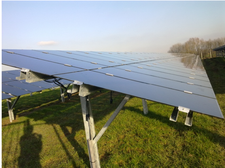
Figuur 5.2: Tafel met (amorfe) zonnepanelen op een open veld locatie
