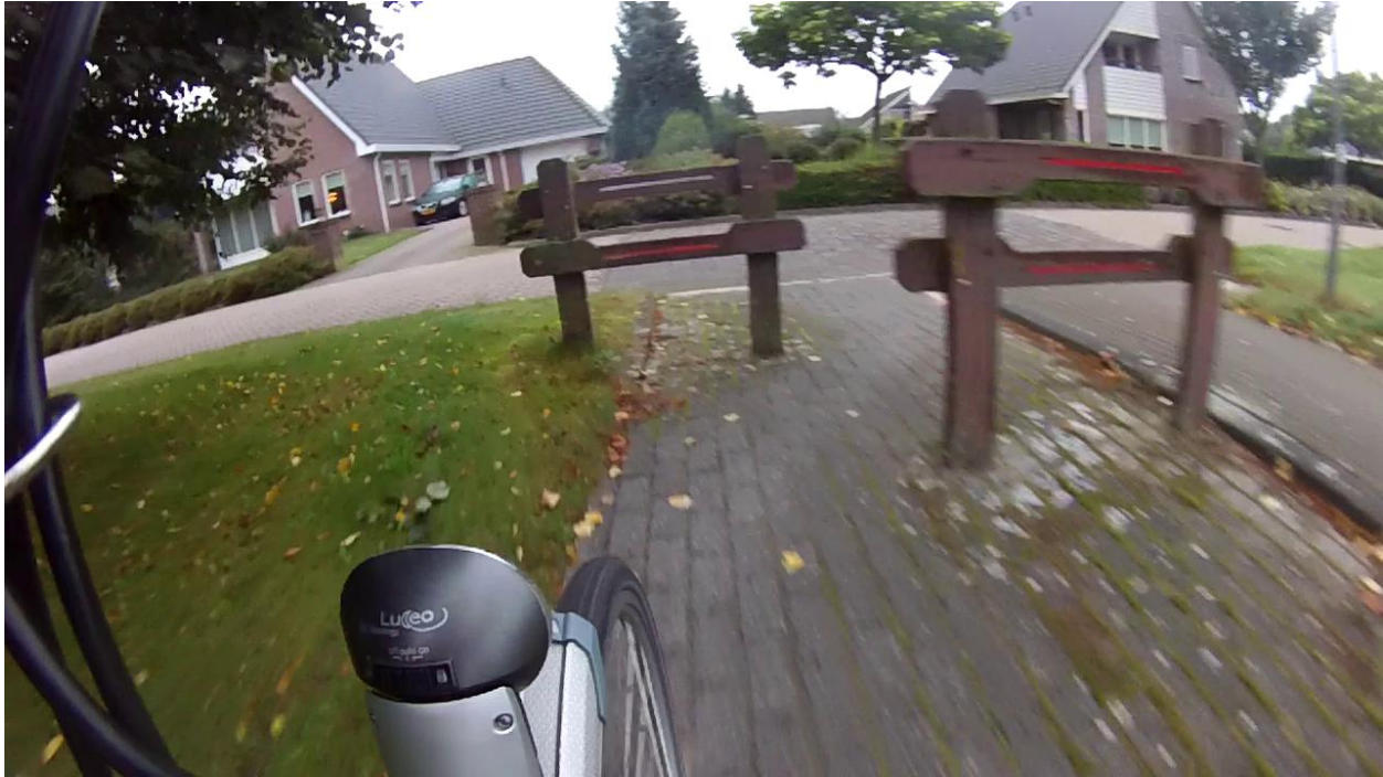
Figuur 11: Een voorbeeld van als potentieel gevaarlijk beoordeelde hekjes op een fietspad.
