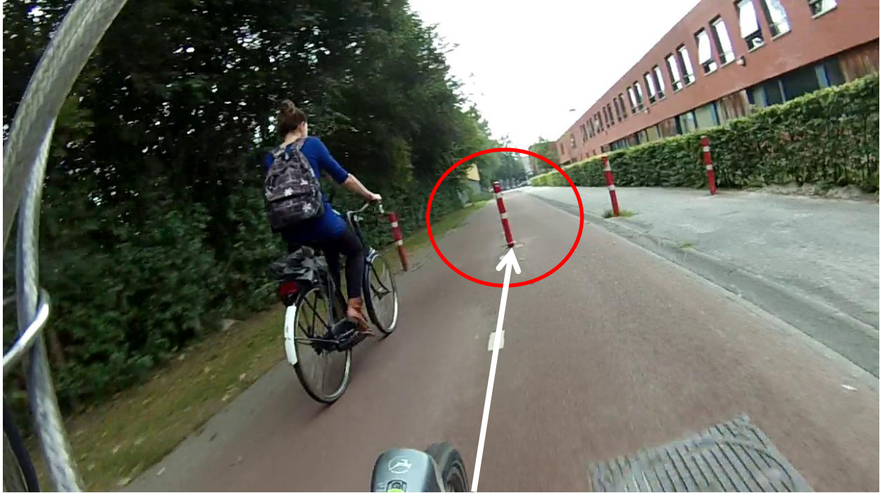
Figuur 14: Een voorbeeld van een door een put ingezette koerswijziging die leidt tot een bots koers richting een fietspaaltje.
