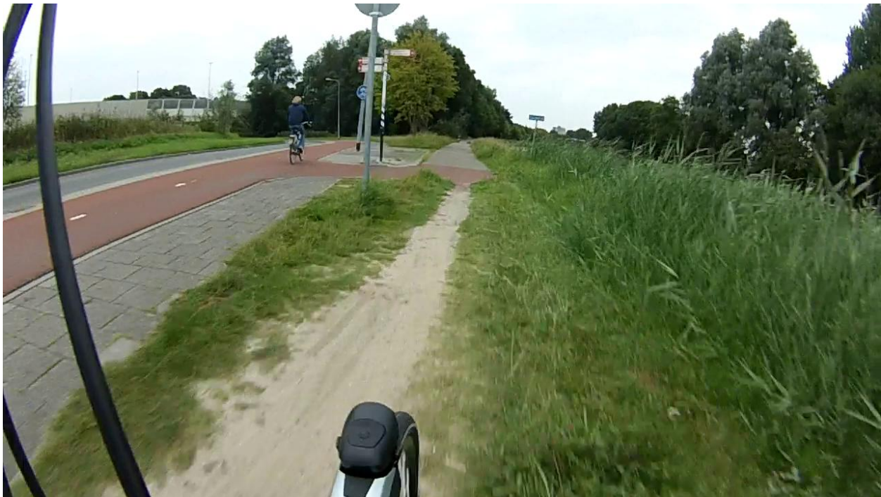
Figuur 17: Een voorbeeld van een ‘olifantenpaadje’ dat ontstaan is na het veelvuldig afsnijden van een scherpe bocht door fietsers.
