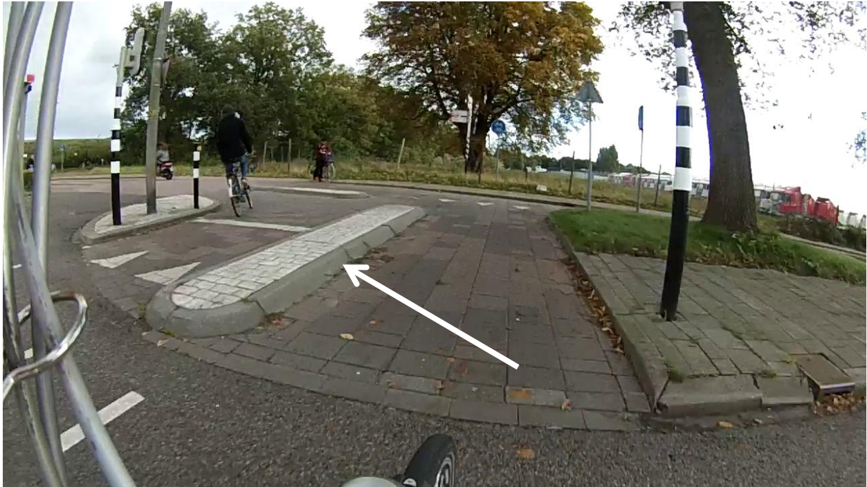
Figuur 10: Een voorbeeld van een als potentieel gevaarlijk beoordeelde verhoging op een fietspad.
