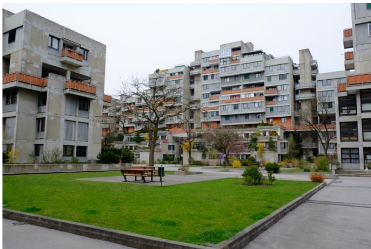
Figure 3. Terrassenhaussiedlung St. Peter/ Graz – 2015
