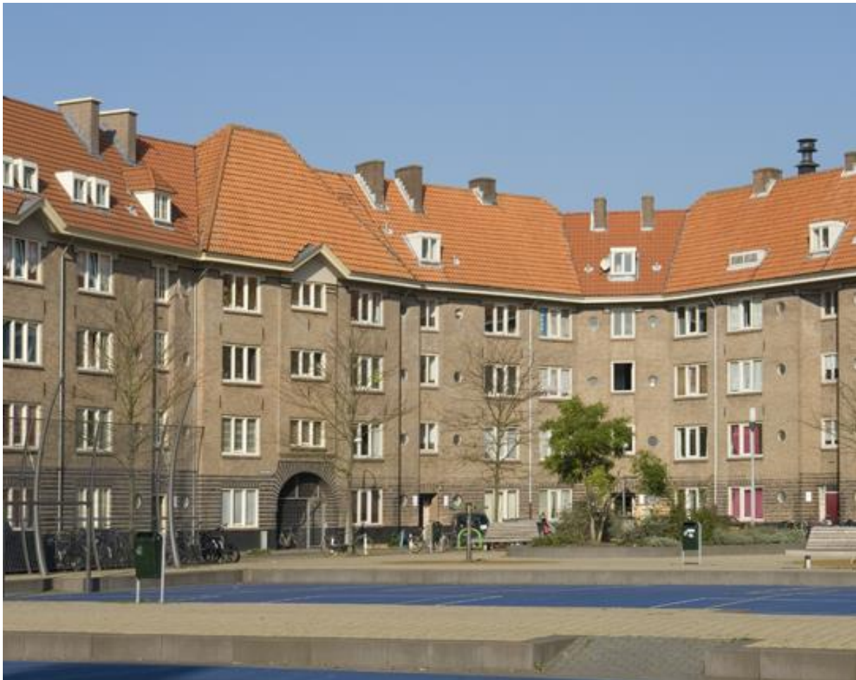
Figure 5: Zaandammerplein (picture Archivolt architecten)
