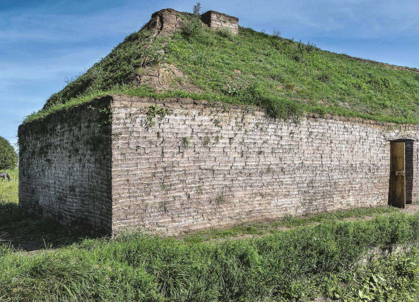
Het gereconstrueerde zandhuis in Firdgum, waarvan de wanden en dakbedekking uit kwelderzoden bestaan. Deze experimentele reconstructie is na een gedeeltelijke instorting volgens een verbeterd ontwerp herbouwd in 2014-2015.
