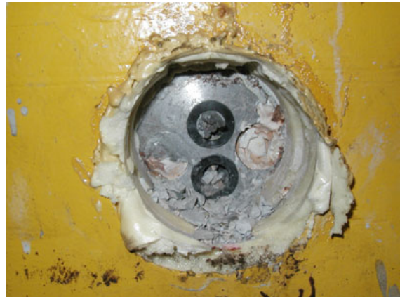
(d) Collapsed section (toward anchor head)
