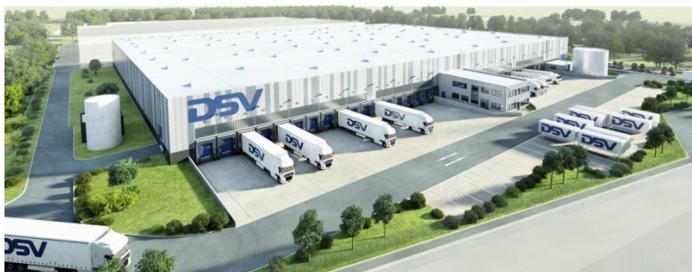
Рисунок 2.3 – Складське приміщення компанії DSV A/S
