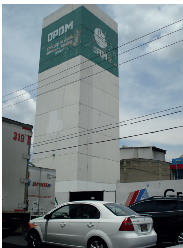
Fig. 5. Rótulo en Tanque de agua identificando el sitio. Fuente: fotografía de Fidencio Mayorga, 2004.
