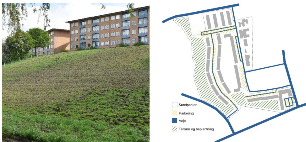
FIGUR 7. Tv. Sundparken set fra Rytterkildedal, hvorfra boligblokkene virker massive ift. skala og størrelse. Th. Kortet viser, de fysiske barrierer i form af vejføringer, parkeringsarealer, beplantning og terrænforskelle i Sundparken.
